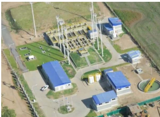
Figura 4. -Foto Planta Potabilizadora Acueducto Centro
