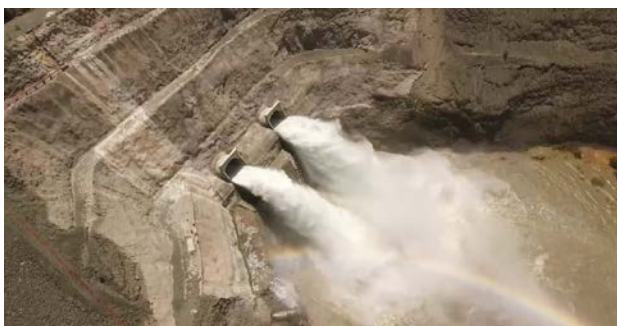
Figura .- 3 Disipador Aprovechamiento Caracoles Hemos representado el lecho cohesivo con arena mezclada con porcentajes de 2 a 4 % de cemento logrando que las formas
