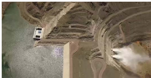
Figura .- 4..Aliviadero Presa y Aprovechamiento Caracoles
