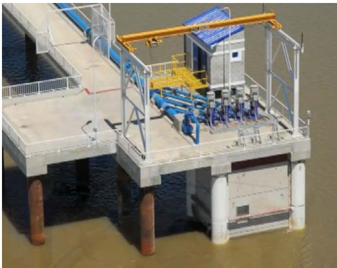
Figura 2. -Foto Obra de Toma Sobre Río Coronda Acueducto Centro
