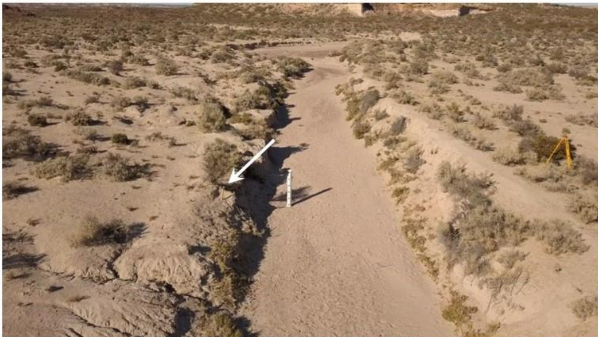
Figura 7. Vista del tramo de estudio hacia aguas arriba. Se distingue la escala hidrométrica apostada sobre el borde derecho del canal (la flecha indica la posición de la cámara).
